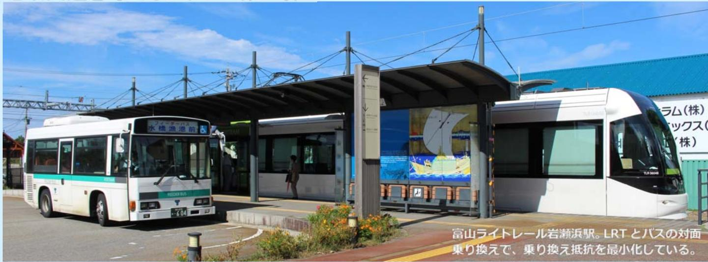
富山ライトレール岩瀬浜駅。LRTとバスの対面乗り換えで、乗り換え抵抗を最小化している。
