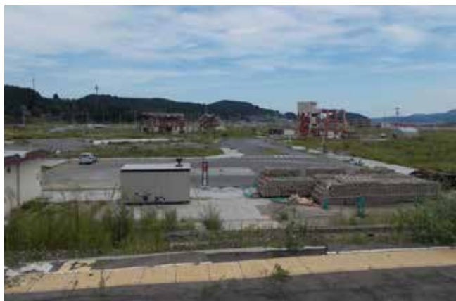
【写真6】旧JR志津川駅から望むがれき撤去後の駅周辺市街地（2012年9月）
