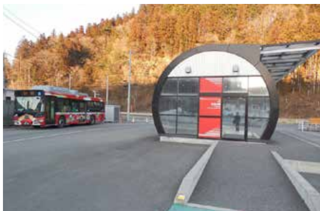
【写真8】南三陸さんさん商店街に隣接した現在のBRT志津川駅（2017年2月）
