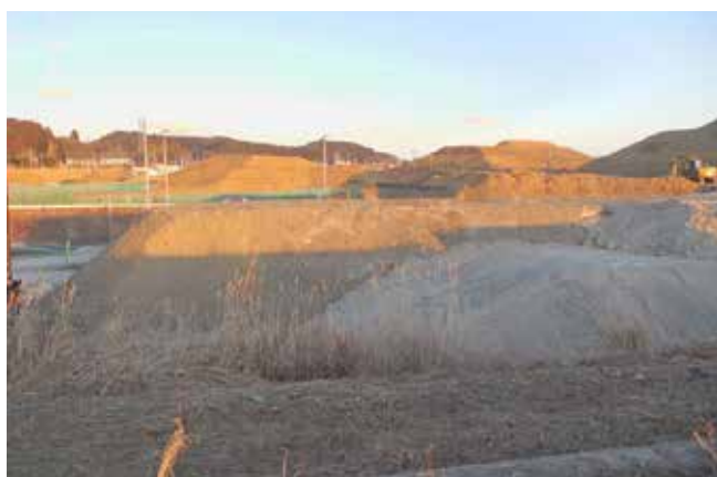
【写真7】盛土で埋まりつつある現在の旧JR志津川駅前（2017年2月）
