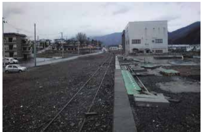
【写真4】がれきとレール撤去が進むJR大船渡駅（2012年3月）
