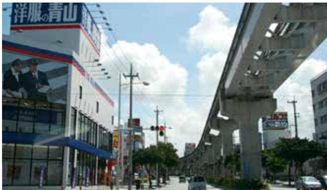
モノレールの走行空間（那覇市）
