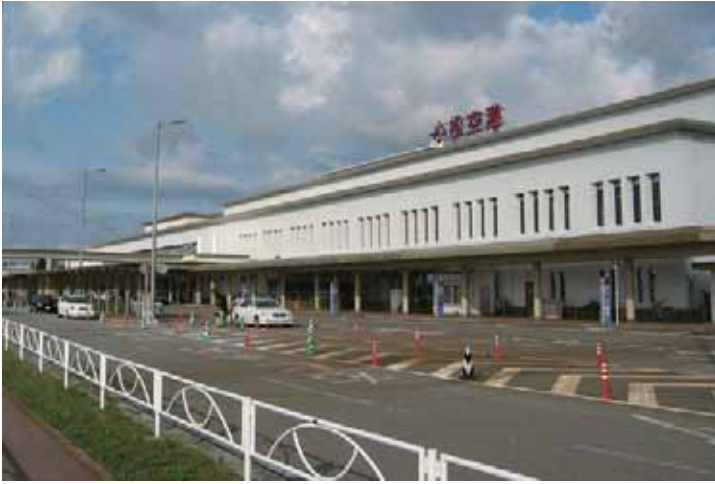
小松空港のターミナルビル 鉄軌道は、空港へのアクセスとしても、速達性、定時性などの面で優れている。
