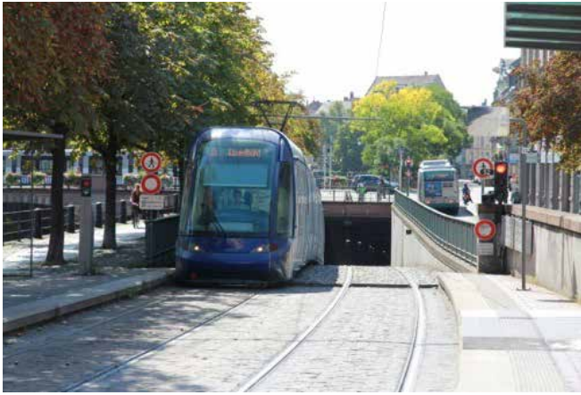
地下線から出る路面電車（ストラスブール）
