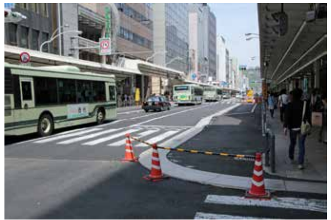
歩道拡幅中の四条通
